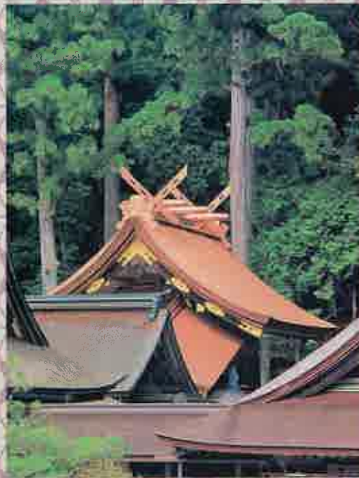
葺き替え後の御本殿
