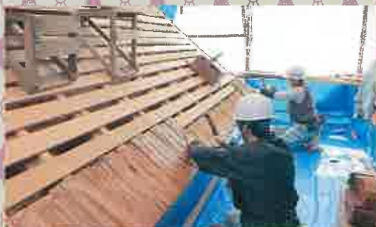
軒付け作業 丁寧に檜皮を重ねてゆきます。
